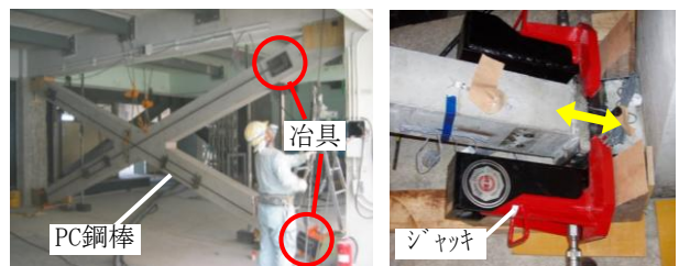
(a) 外ケーブル緊張方式 (b) あと圧着方式
