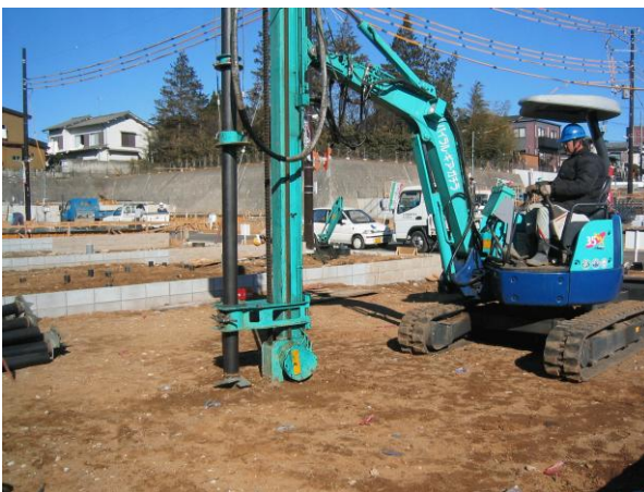
コンパクトな施工機械
