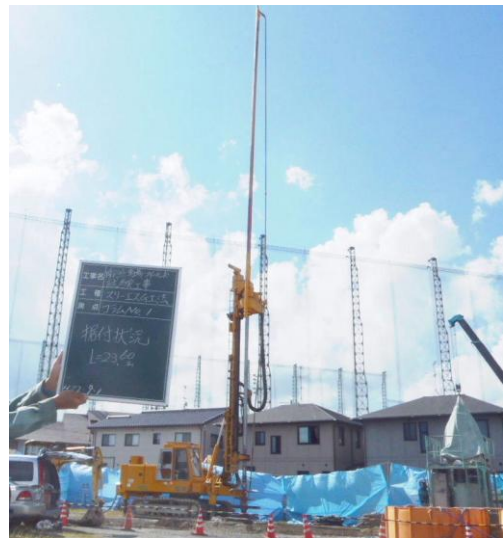
写真-1 最大改良長 20.5mの施工状況
