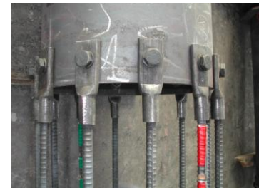
図-2 鉄筋取付け部
