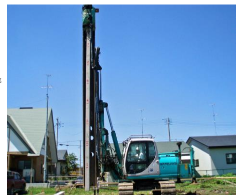
写真-1 施工状況
