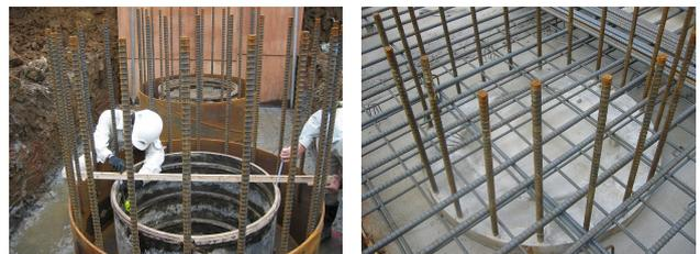
図-2 拡頭リングの設置状況
