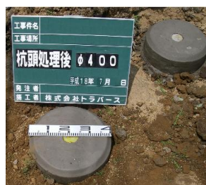
写真-1 頭部状況
