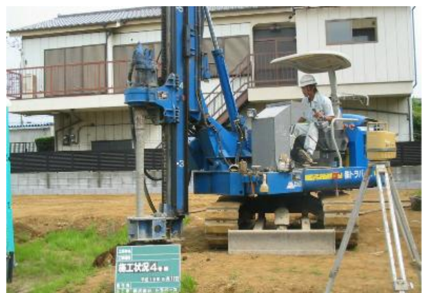
写真-3 タイガーパイル工法施工状況
