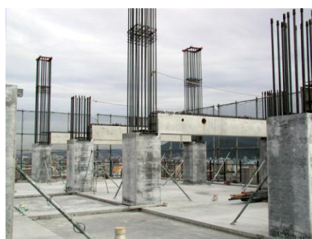
写真2 エココラム建て込み状況
