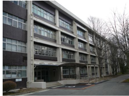
施工例：宮城教育大学／施工（株）コンステック
