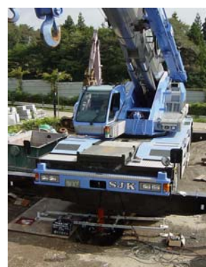
写真2 載荷試験状況
