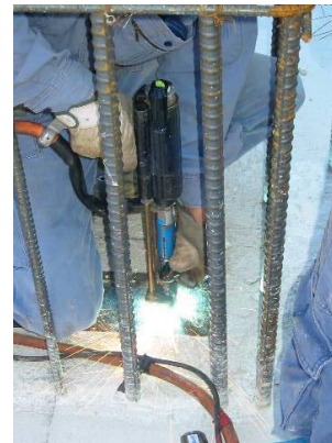
スタッド溶接施工状況
