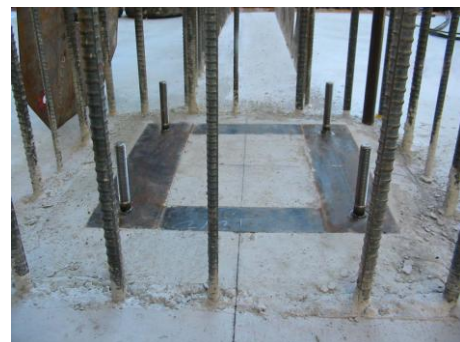
ベースアンカー施工完了
