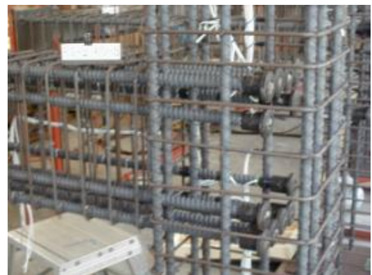
写真 1 ト形接合部配筋（側面）
