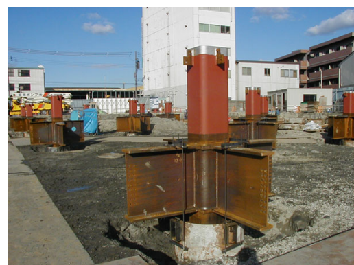
施工実施状況
