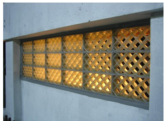
既存腰壁上部に FRP ブロックを組積した増設耐震壁
