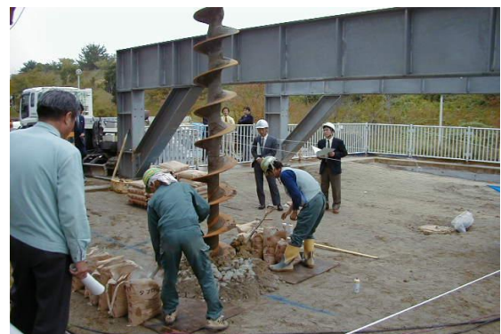
固化材添加状況
