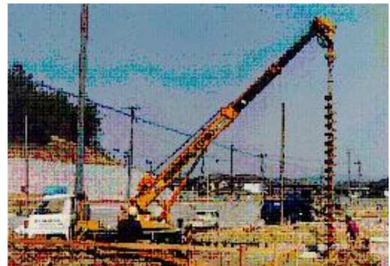
施工状況全景
