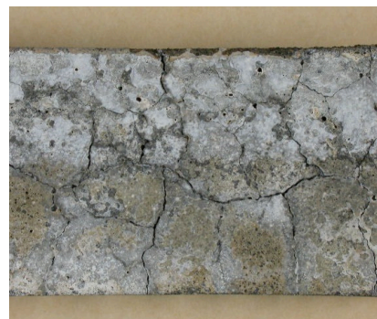
「無害でない」のモルタル供試体の例
