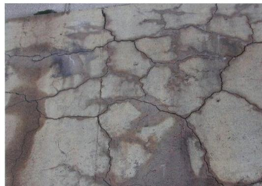
写真1 アルカリシリカ反応によって生じたコンクリートのひび割れ損傷
