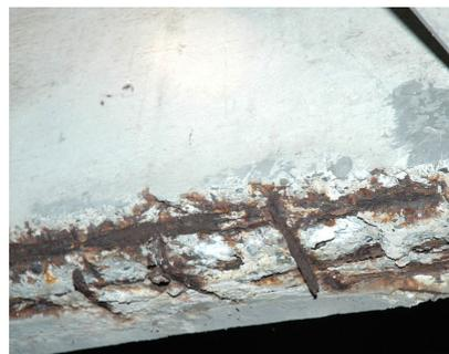
写真1 発生した錆の膨張圧によるかぶりコンクリート(梁下面)の剥落
