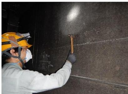
コンクリート表面の変色や煤の付着、ひび割れ等の状況を目視観察します。ひび割れ発生箇所はハンマーで打診し、コンクリートの浮きの有無を確認します。
