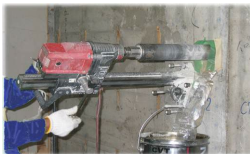
コンクリートコアの切り取り状況
