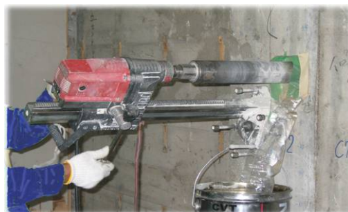
コンクリートコアの切り取り状況
