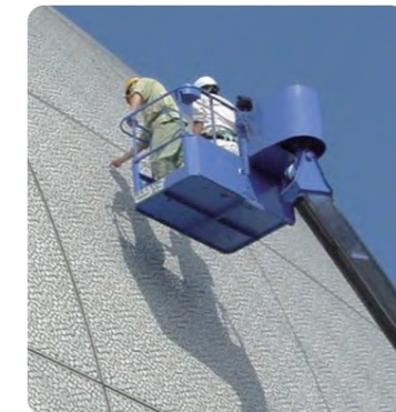
高所作業車による調査
