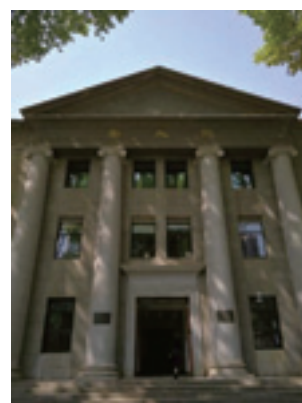
写真-3 建築学院の中心的建築・中大院
