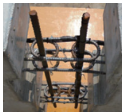
図-3 PCa接合部の施工例
