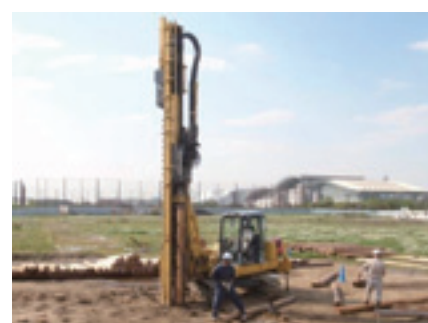
図-2 丸太打設状況
