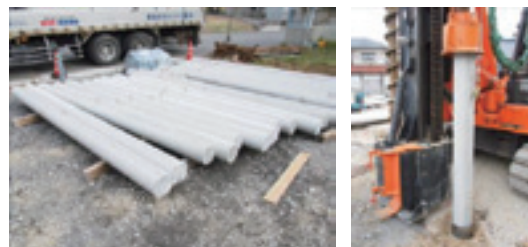
写真-1 補強材および施工状況
