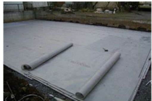
写真 シートの敷設状況
