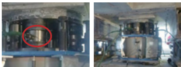
写真-4 免震プレロード加力状況
