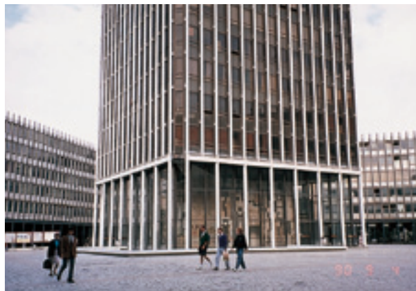
写真-29 高層事務所棟の円形CFT柱
