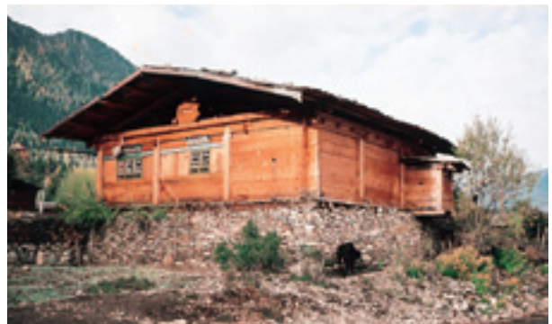
写真-10 東チベットの石積壁と板ログによる民家
