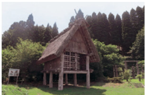
写真-8 復元された掘立柱と貫による高床式建物
