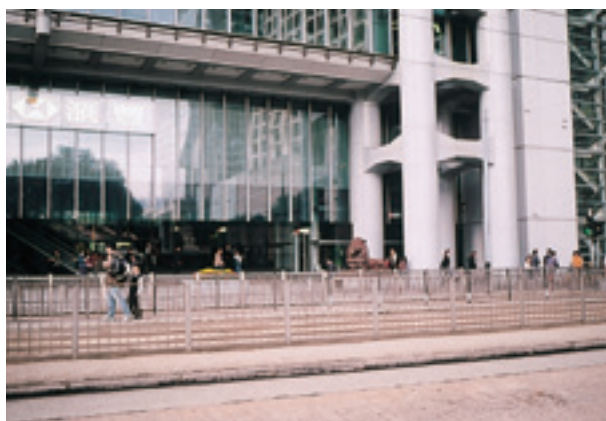
写真-31 円形鋼管4本による格子柱
