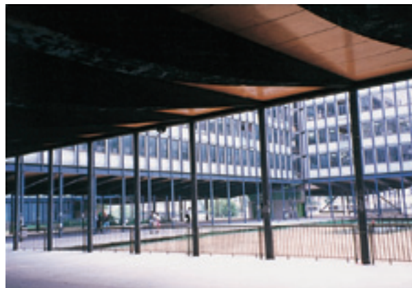
写真-27 円形CFT柱による教育・研究棟
