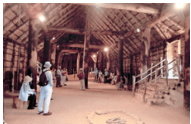
写真-3 写真-2の内部の掘立柱構造
