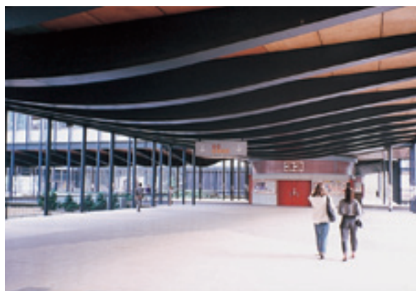
写真-28 スパン15mの鉄骨箱形変断面梁
