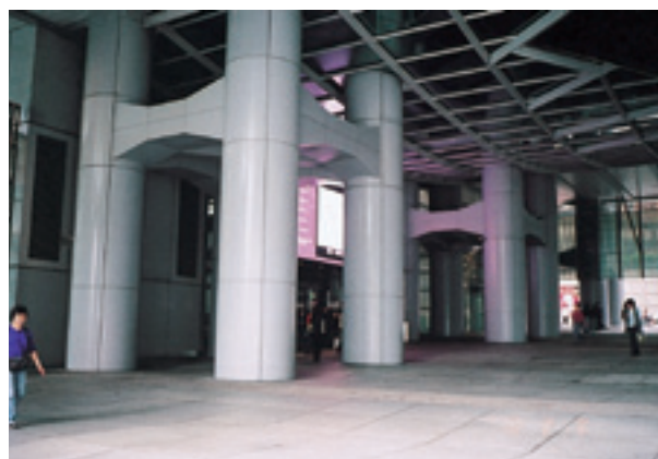
写真-33 ピロティー形式の地上部分
