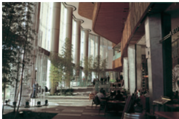
写真-36 「虎の門ヒルズ」の外周1階円形CFT柱列
