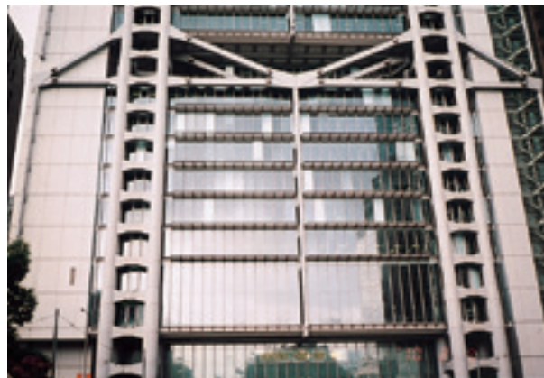
写真-32 格子柱・トラス梁・床を支える引張材の構成
