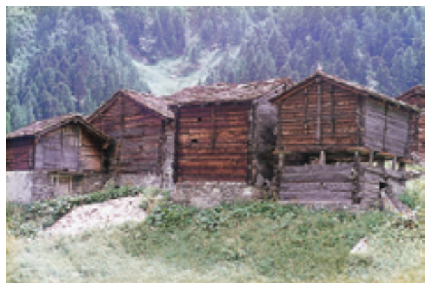
写真-23 農村のログハウスによる倉庫
