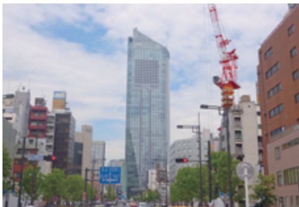
写真-35 地階を環状2号線が通る「虎の門ヒルズ」
