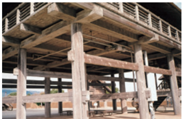
写真-6 復元された大型高床式建物の貫構造
