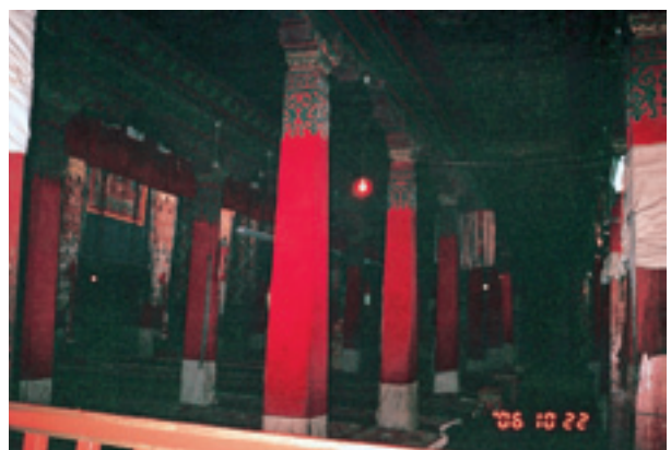
写真-12 木柱列で支える寺院の大空間
