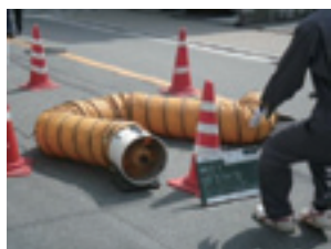
管路内の換気作業
