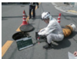
交通整理・ガス濃度の測定
