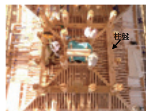
写真-5.14 側柱の柱盤
