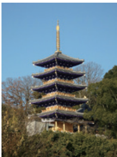
写真-4.1 中山寺五重塔の全景
