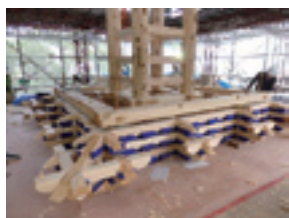
写真-5.10 柱盤上の四天柱
