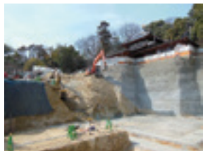
写真-5.1 掘削工事
