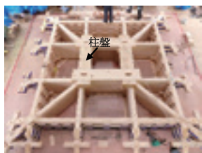
写真-5.9 四天柱の柱盤
