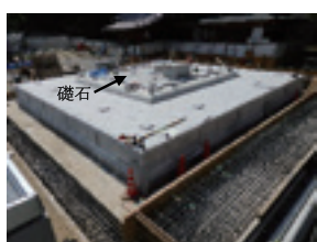
写真-5.3 基礎工事(基壇)
