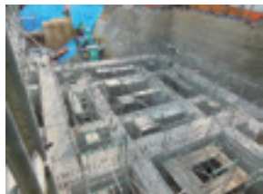
写真-5.2 基礎工事
