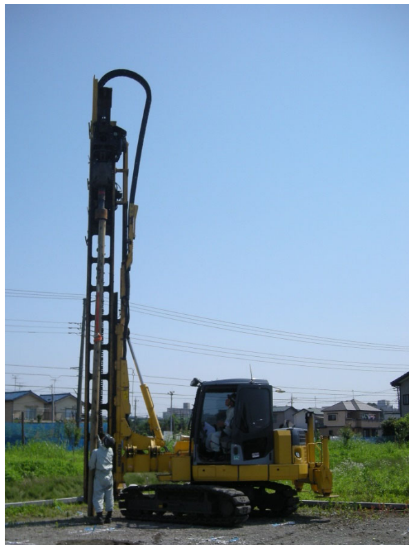
写真-1 施工状況
