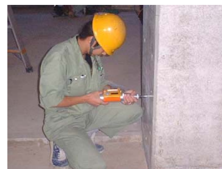
写真 4 : コンクリートの反発度の測定状況
