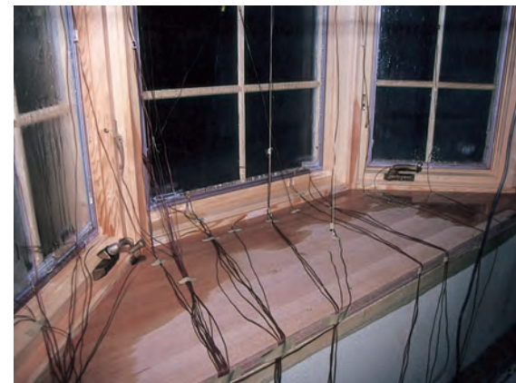
出窓の結露試験
