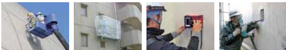
高所作業車による外壁調査
