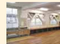
耐震補強後の建物例
