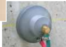
コンクリートの透気係数測定
