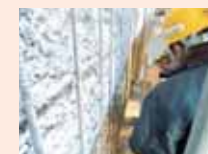
検証後の工事確認
