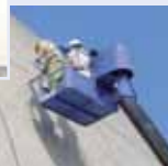
高所作業車による外壁調査
